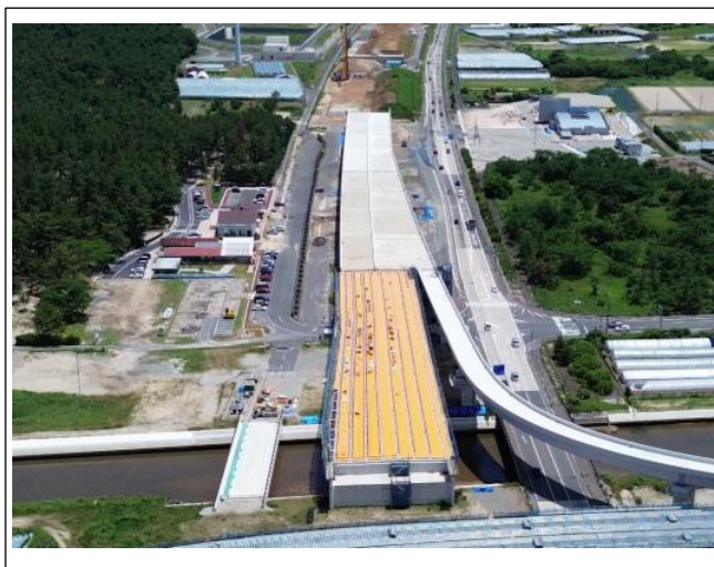
施工状況（米子方面より）
