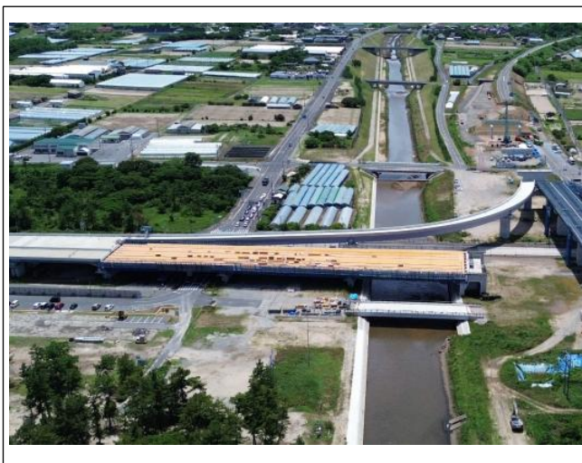
施工状況（海側より）
