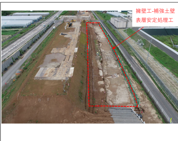
施工状況（国坂）
