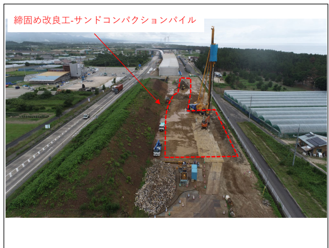
施工状況（国坂）
