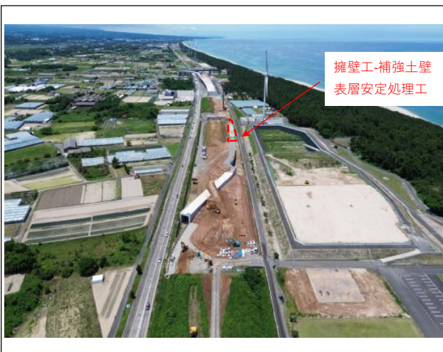
施工状況（国坂）
