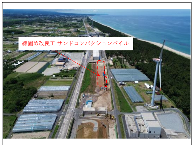
施工状況（国坂）
