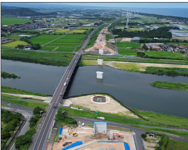
起点側（湯梨浜町はわい長瀬より）
