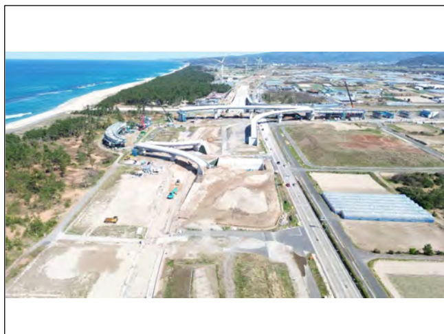
工事現場西側より撮影
