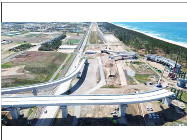
工事現場東側より撮影
