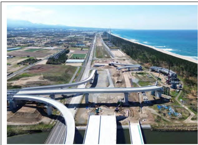
工事現場東側より撮影
