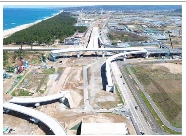
工事現場西側より撮影
